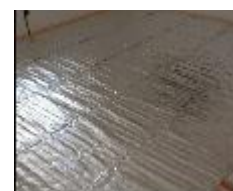
Rozložení rohože na 0,5 cm izolaci.
