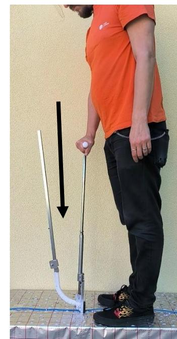
Použitie Tackera je vhodné pre tvrdené izolácie, napríklad extrudovaný polystyrén.
